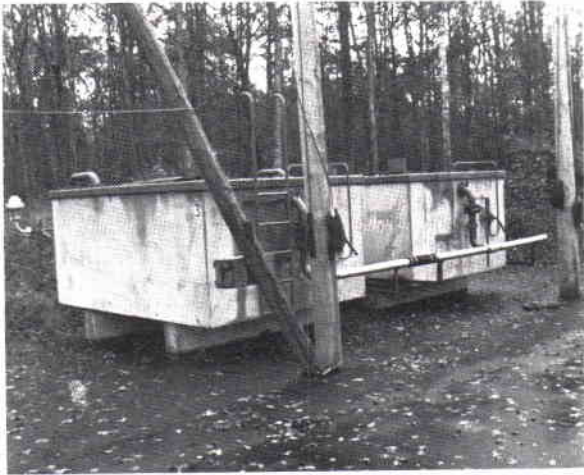
De nya betongsisternerna vid F7.
